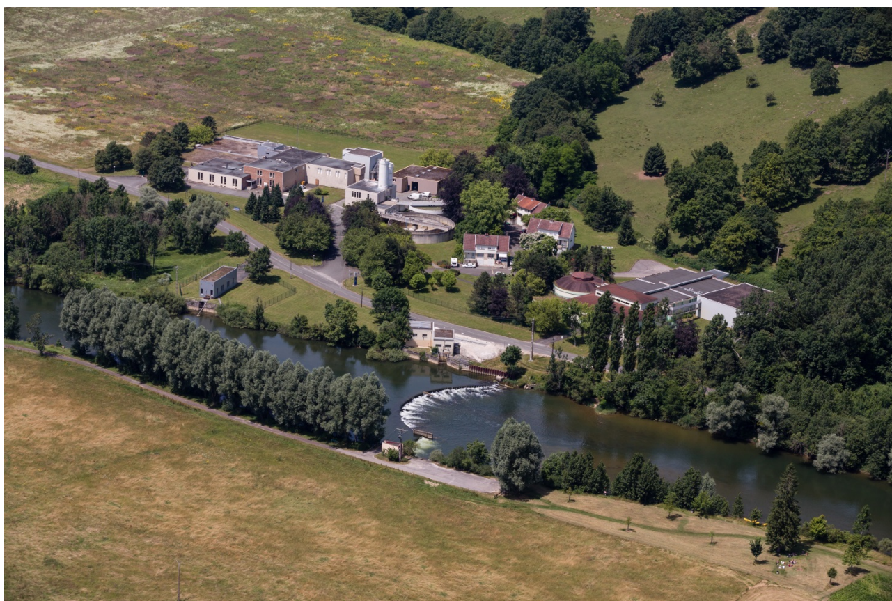
Usine d'eau potable de Mathay
