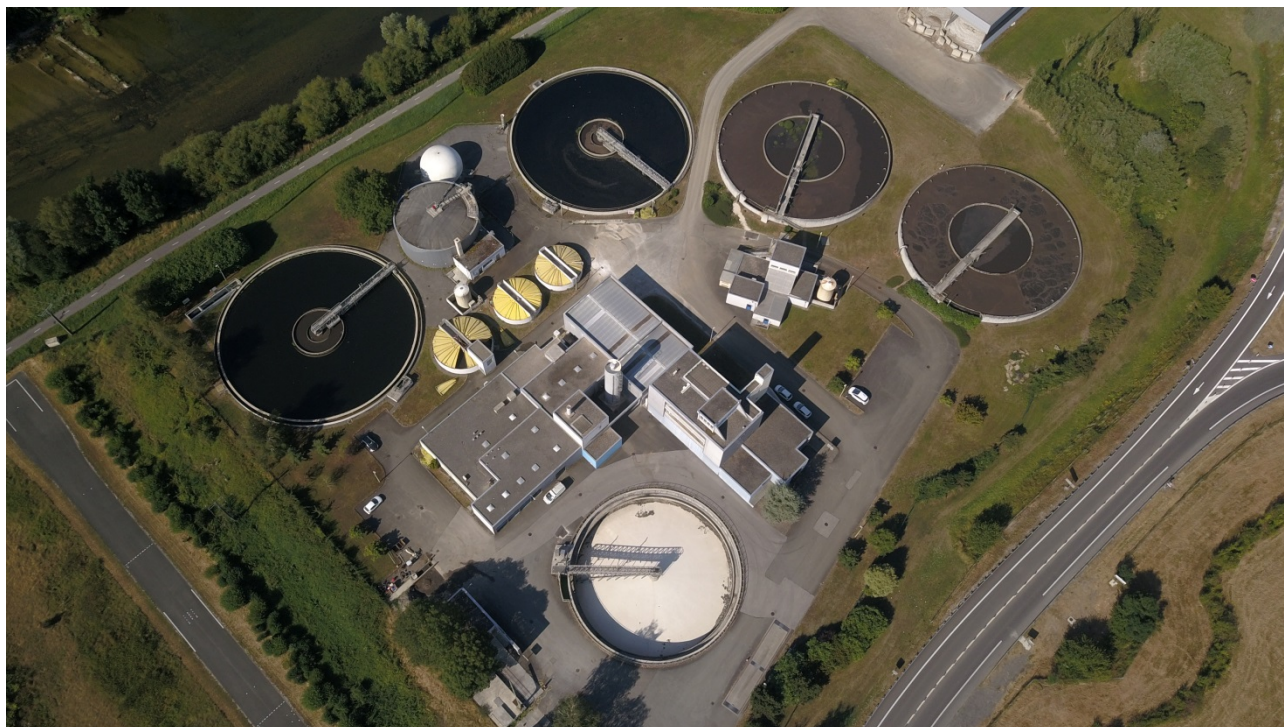
Station d'épuration d'Arbouans
