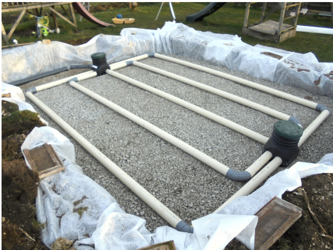
Contrôle d'une installation ANC en construction à Ecot
